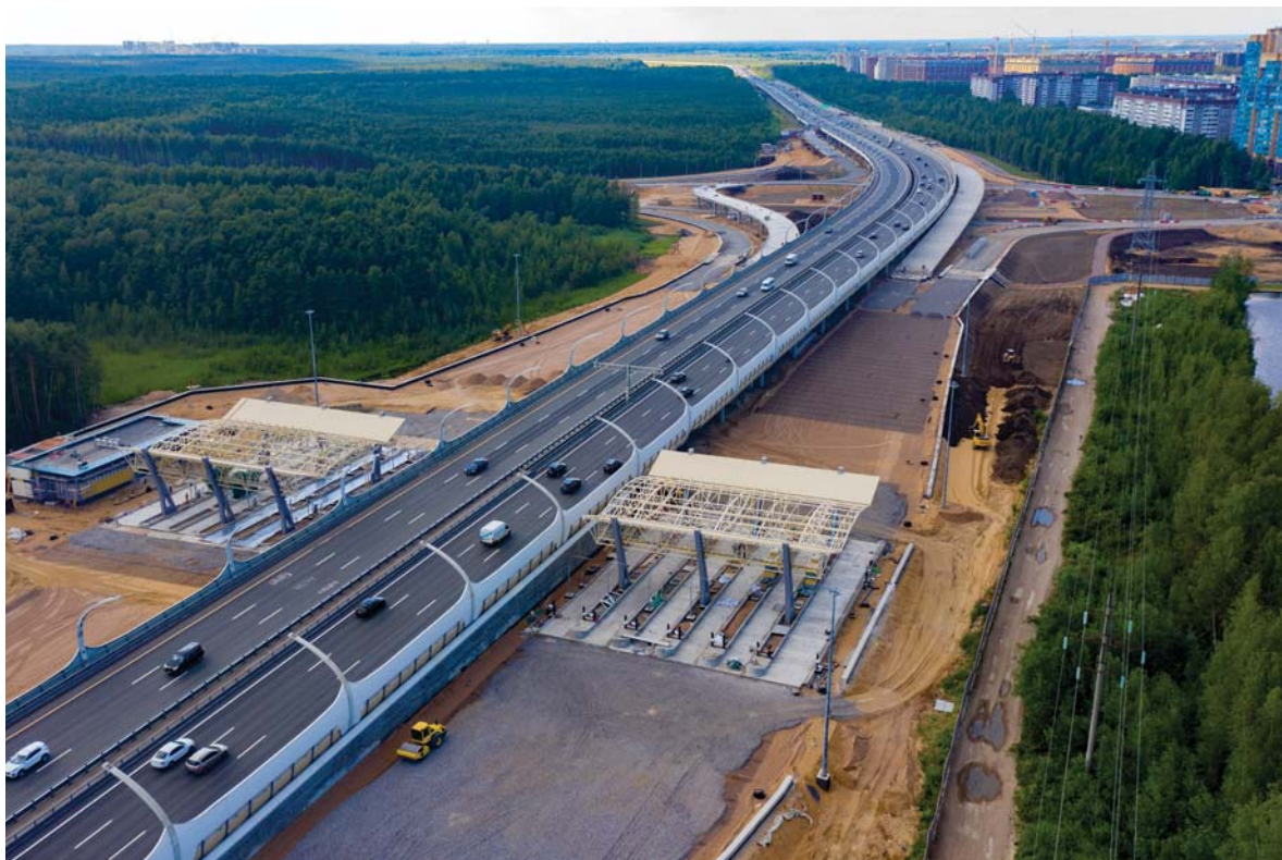
Транспортная развязка автомобильной дороги «Западный скоростной диаметр» (ЗСД) на пересечении с Шуваловским проспектом. Санкт-Петербург
