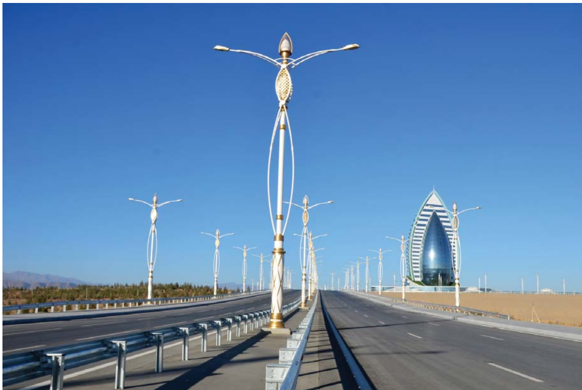
Строительство автомобильных дорог к пятизвездочному отелю Ашхабад, Туркменистан
