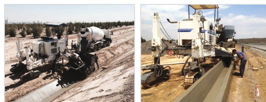
Производство монолитных водоотводных лотков V-образной и U-образной формы. Южная кольцевая автодорога. Туркменистан
