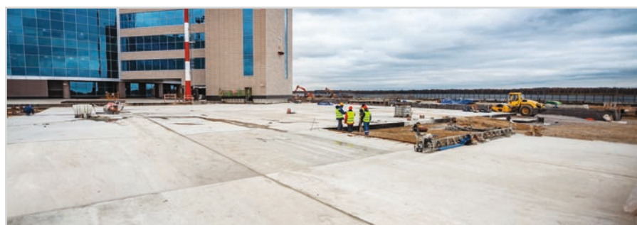
Этапы реконструкции. Аэропорт Домодедово. Москва
