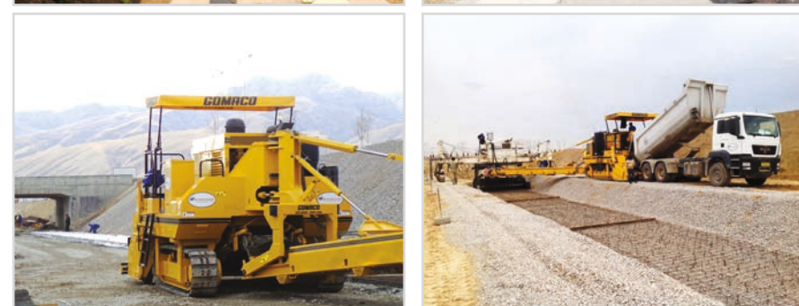
Строительство деривационного канала. Туркменистан
