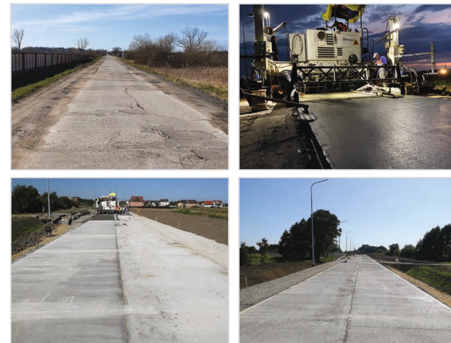
Капитальный ремонт автомобильной дороги «Вишневое-Сосновка-Вербное-Гусево» в Калининградской области
