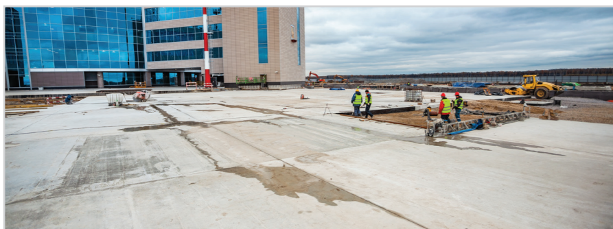
Этапы реконструкции. Аэропорт Домодедово. Москва
