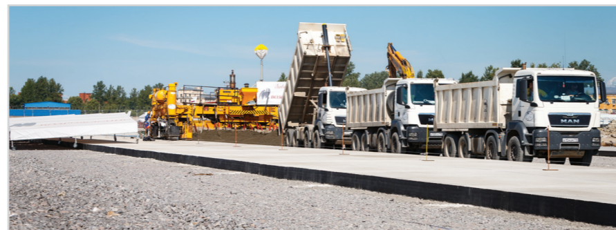
Этапы реконструкции. Аэропорт Пулково-2. Санкт-Петербург
