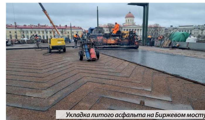
Укладка литого асфальта на Биржевом мосту
