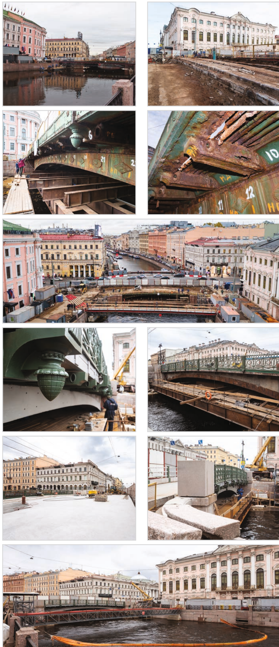
Этапы реконструкции. Зеленый мост. Санкт-Петербург
